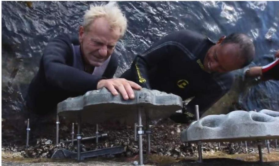
Méthodologie de pose et fixation unitaire des dallettes écoconçues le long de la paroi verticale d'un ouvrage maçonné existant
