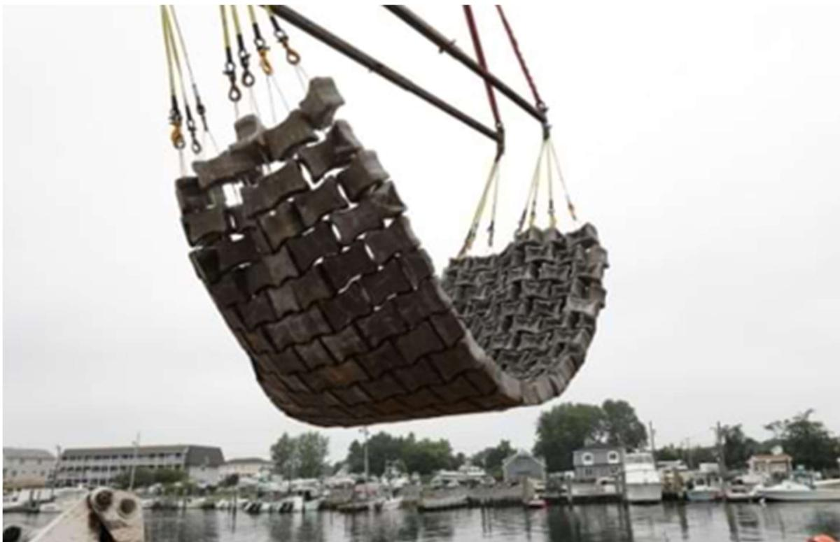
Matelas stabilisateur écoconçu (source : [econcretetech.com](http://econcretetech.com))
