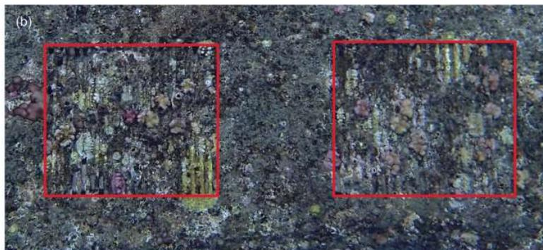
Blocs de digues manufacturés intégrant des rainurages adaptés au recrutement corallien installés en pieds d'ouvrage jusqu'à -20 m de profondeur (Source : Tanaya et al., 2021)
