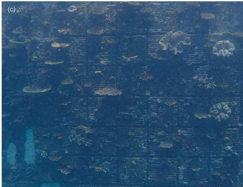
Parements d'ouvrages verticaux intégrant des rainurages adaptés au recrutement corallien installés le long des profondeurs intermédiaires de l'ouvrage depuis la surface jusqu'à -5m de profondeur (Source : Tanaya et al., 2021)
