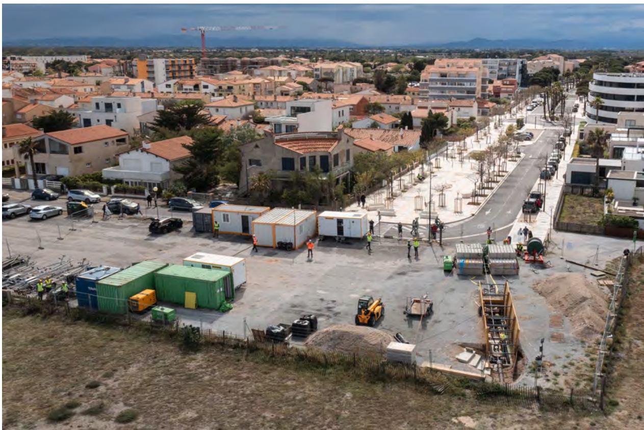
Parking préparé pendant le tirage
