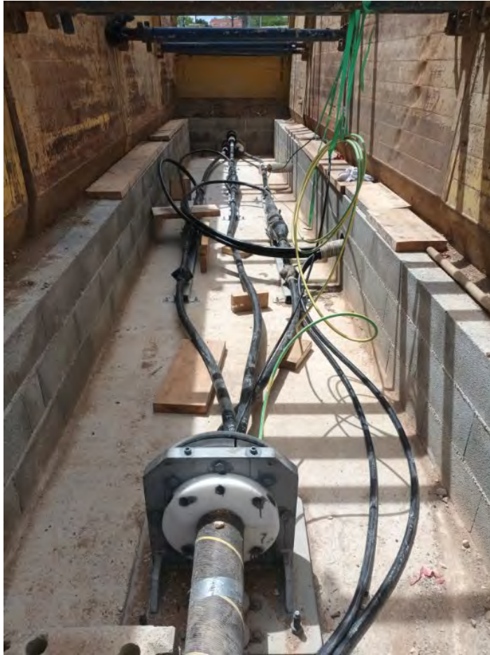
Jonctions d'atterrage et beach clamp
