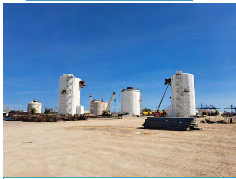
Mise en place des colonnes et installation de bracings
