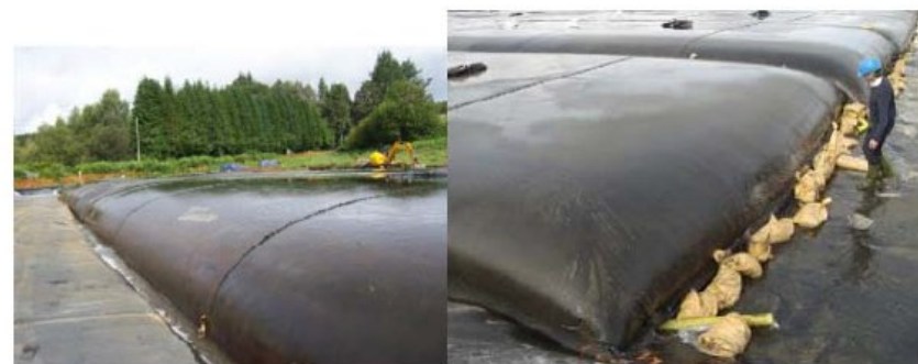
Exemples de géo conteneurs filtrants en cours de remplissage
