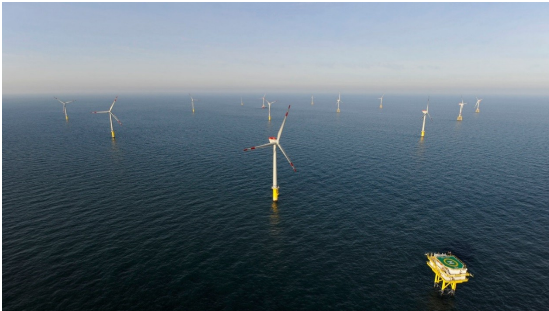
Figure 11: Illustrations d'une ferme commerciale éolienne offshore sur fondations posées (sous-station électrique au premier plan)
