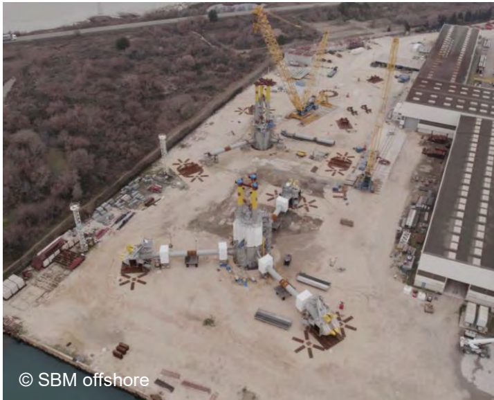
Assemblage des flotteurs sur le site Eiffage Métal de Fos
