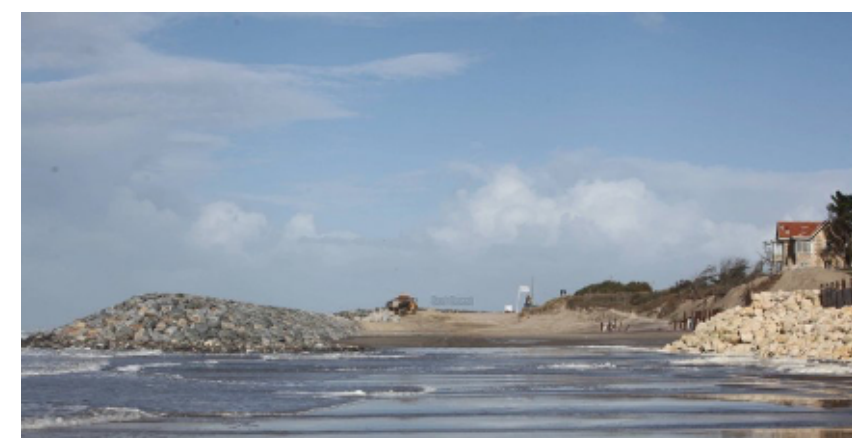
Soulac-sur-mer, baie de l'Amélie fermée par un ouvrage maritime de protection en enrochement de 145 mètres de long après les tempêtes de 2014 (Photo J. Lestage, Sud Ouest, 10/11/2014)
